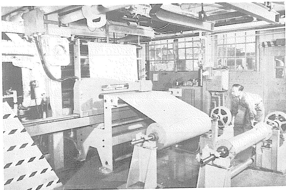
Apparecchio di precisione usato nell'industria per la misura ed il controllo di piccoli spessori («spessimetro a radioisotopi» in una grande cartiera) (Usis).
