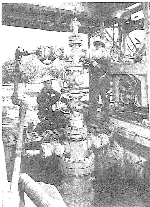
Pozzo petrolifero dell'Agip presso Gela: particolare della testa di erogazione («albero di Natale»), costituita da un complesso di pompe e valvole (Agip).
