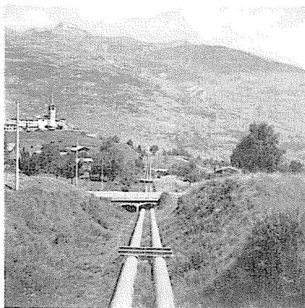
Condotte forzate per l'alimentazione di potenti turbine idrauliche.
